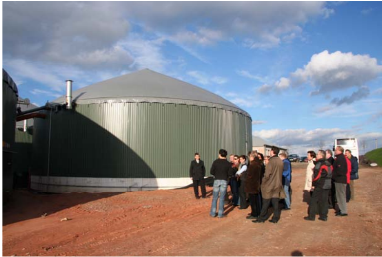
Bürgerkraftwerk Biogasanlage Markushof, Losheim am See (2007)
