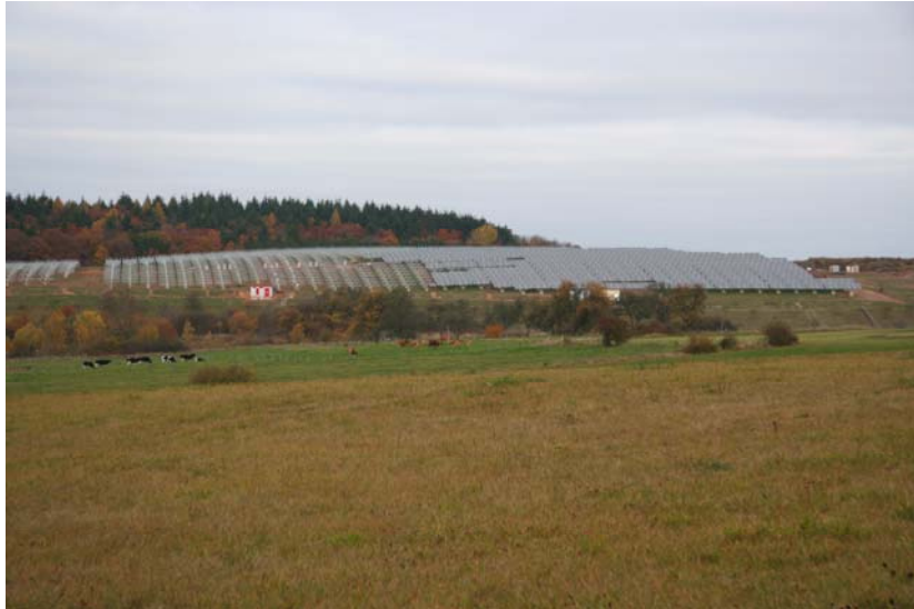
Im Bau befindlicher Solarpark auf der ehemaligen EVS-Mülldeponie in Merzig-Fitten (Sommer 2007)
